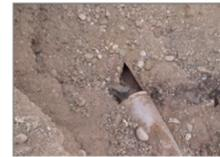
Defekter Anschlusskanal bei offener Baugrube
